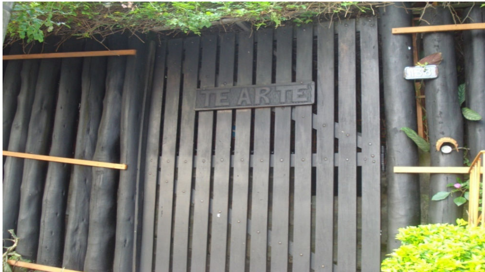
Fotografia 2 – Portão de entrada
